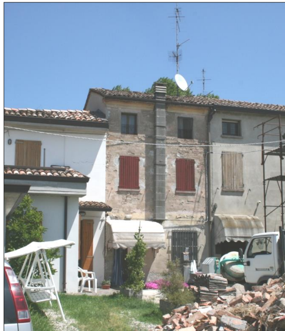
Foto da via Chiesa Sud (cortile interno)
