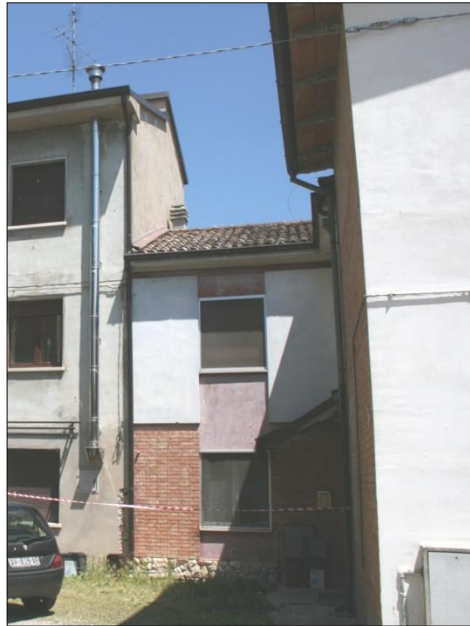
Foto da via Chiesa Sud (cortile interno)
