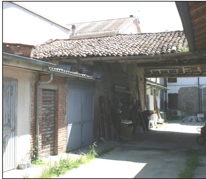
Foto da via Zoldi (cortile interno)
