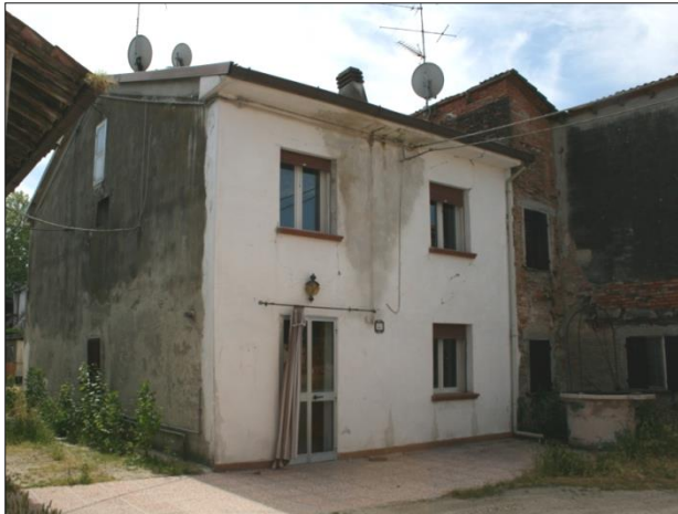
Foto da via Borgoferro (cortile interno)
