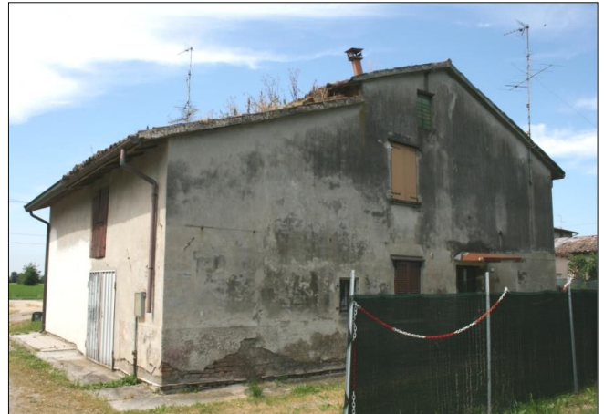
Foto da via Borgoferro (cortile interno)
