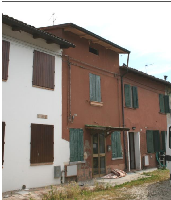
Foto da via Borgoferro (cortile interno)
