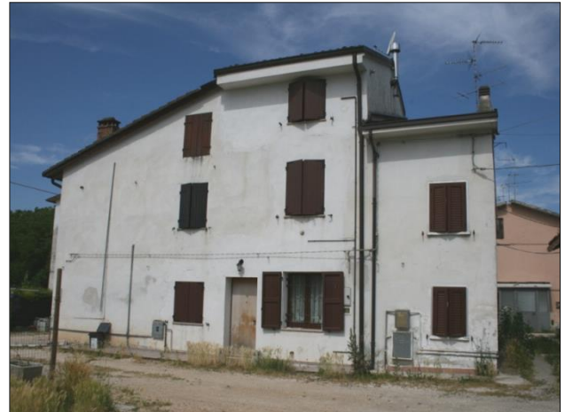
Foto da via Borgoferro (cortile interno)
