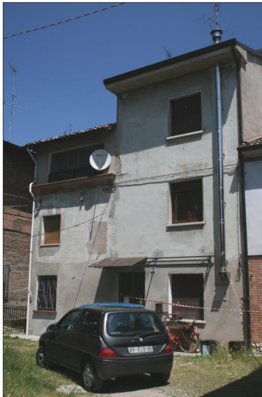
Foto da via Chiesa Sud (cortile interno)
