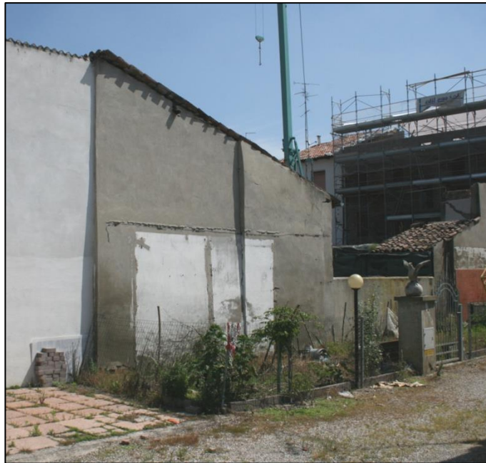
Foto da via Zoldi (cortile interno)
