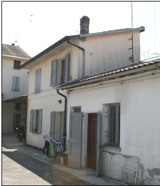
Foto da via Zoldi (cortile interno)
