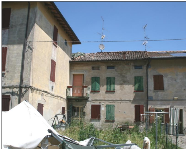
Foto da via Chiesa Nord (cortile interno)
