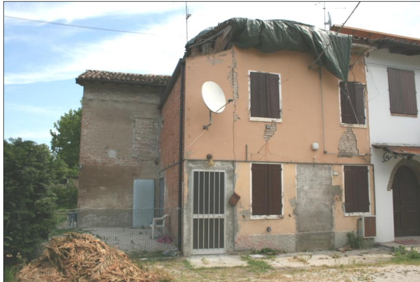
Foto da via Borgoferro (cortile interno)
