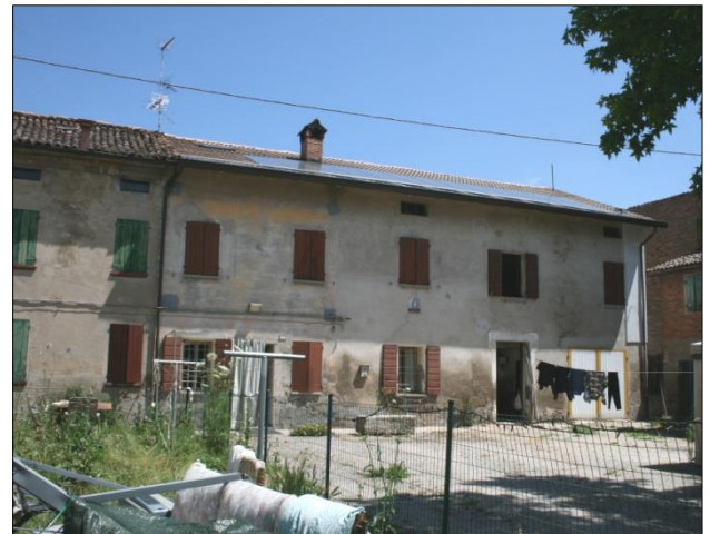
Foto da via Chiesa Nord (cortile interno)
