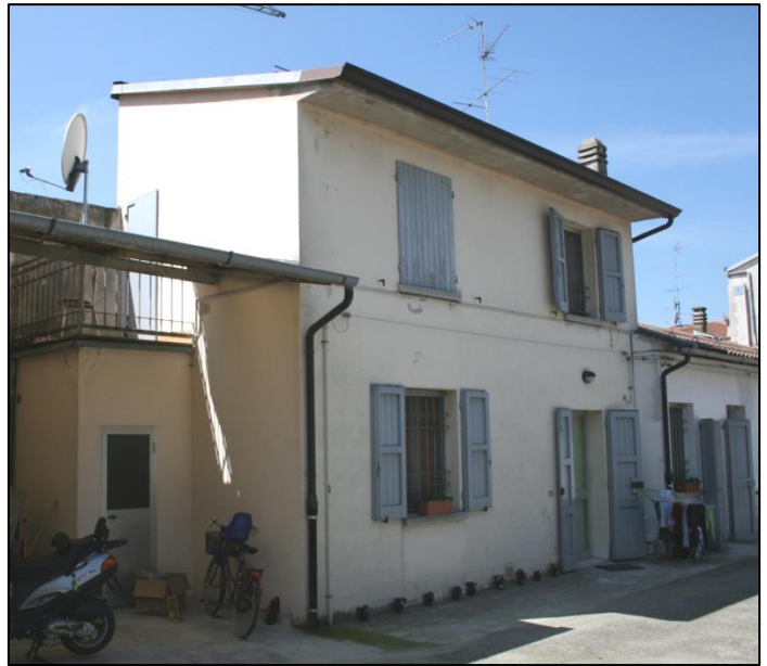
Foto da via Zoldi (cortile interno)
