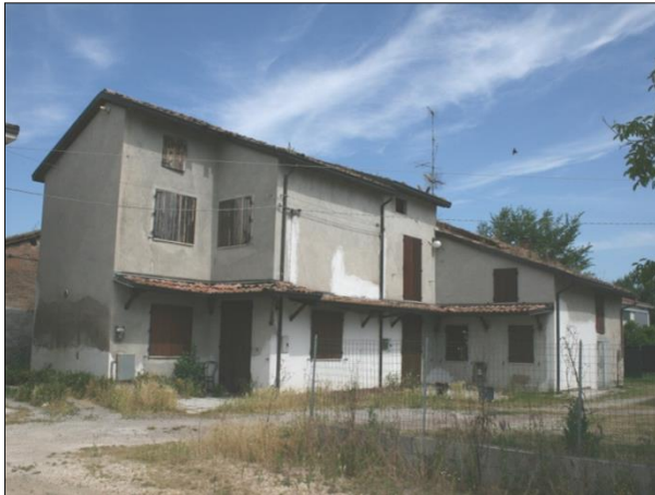
Foto da via Borgoferro (cortile interno)
