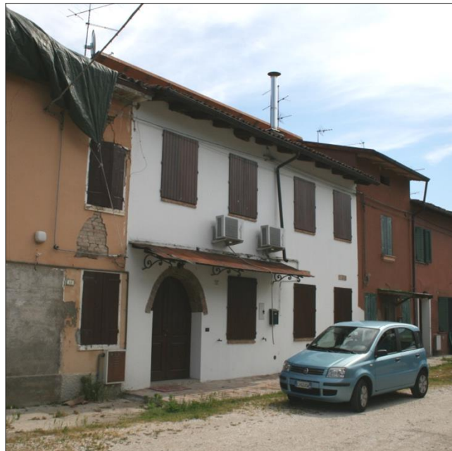
Foto da via Borgoferro (cortile interno)
