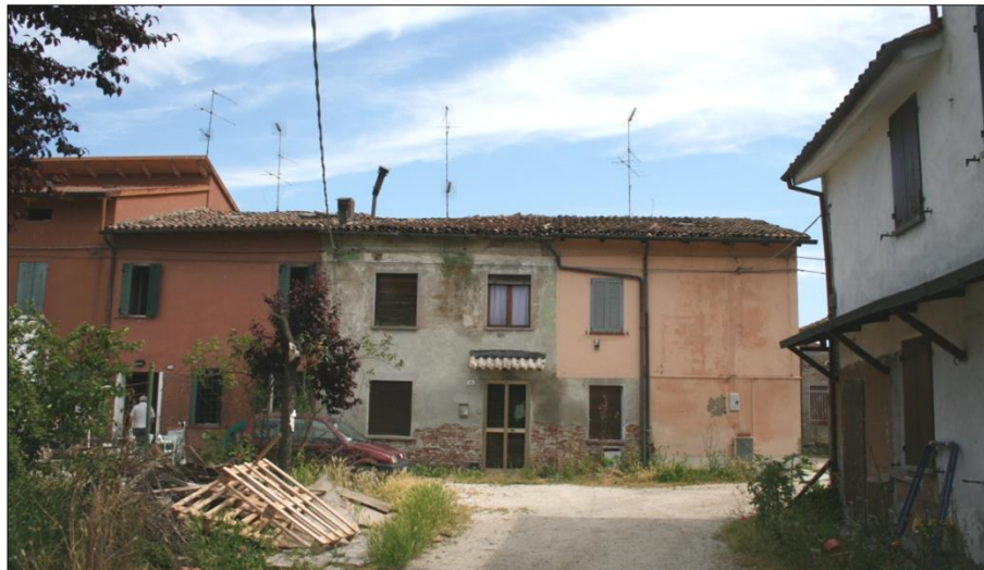
Foto da via Borgoferro (cortile interno)
