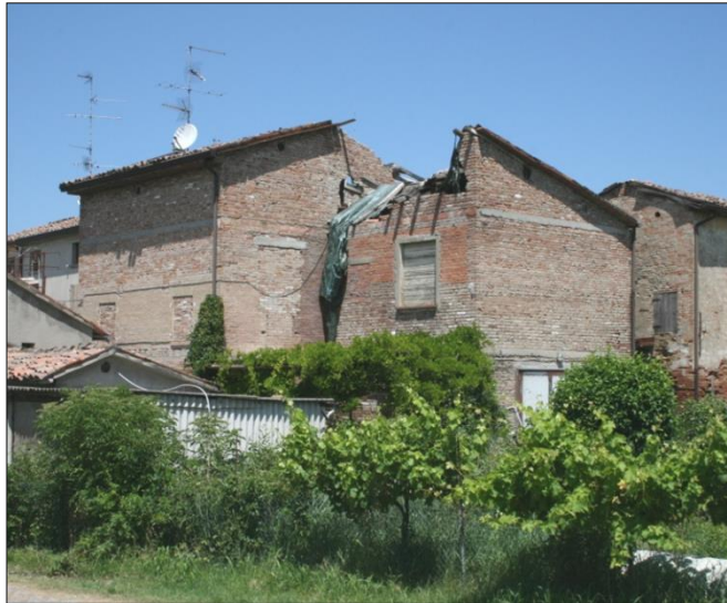
Foto da via Chiesa Sud (cortile interno)
