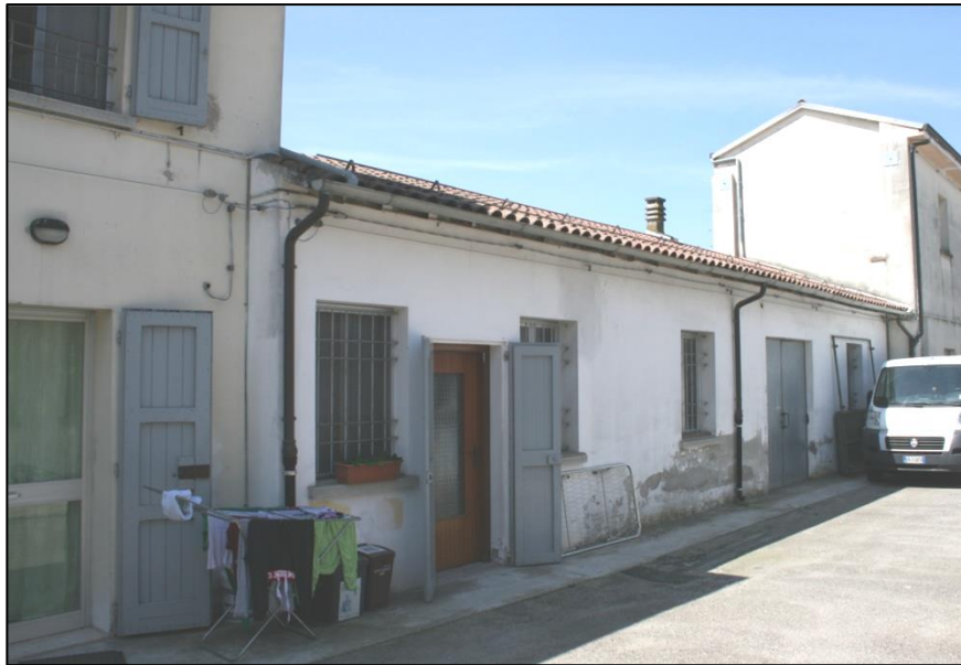
Foto da via Zoldi (cortile interno)
