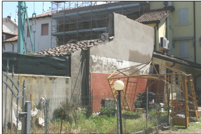
Foto da via Zoldi (cortile interno)
