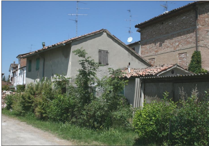
Foto da via Chiesa Sud (cortile interno)
