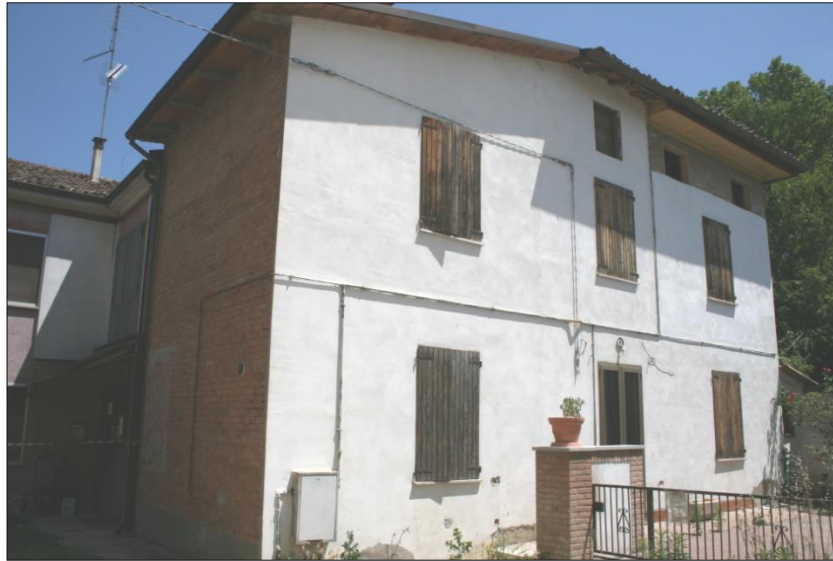
Foto da via Chiesa Sud (cortile interno)
