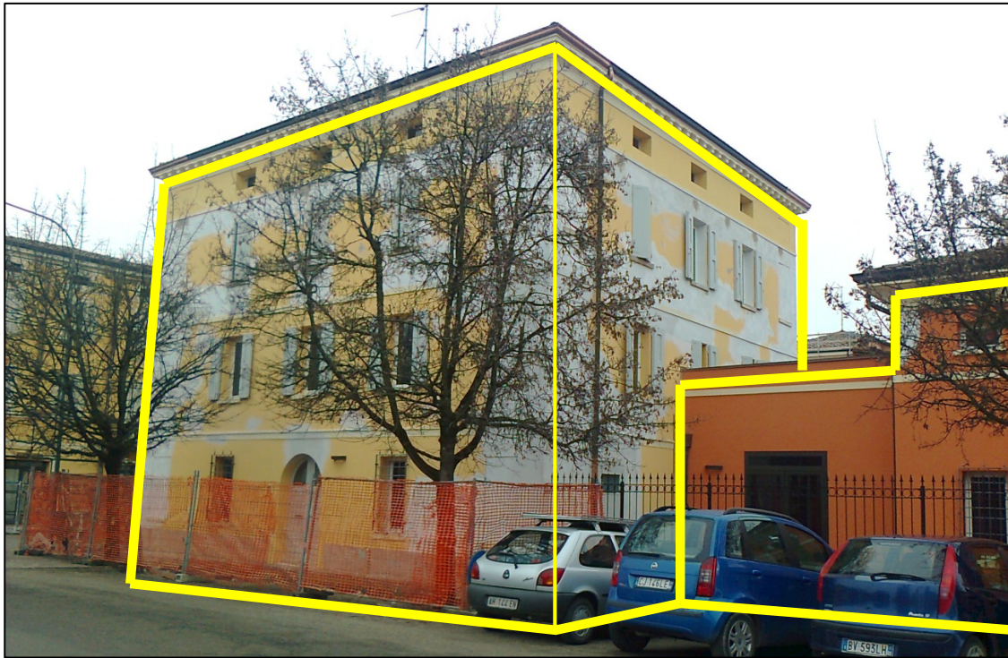
Elementi di confine di limitata interferenza strutturale (collegamenti di limitata estensione plani-volumetrica con forte discontinuità strutturale)
