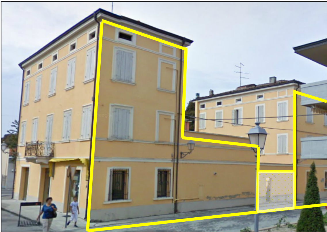
Elementi di confine di limitata interferenza strutturale (muro di recinzione)
