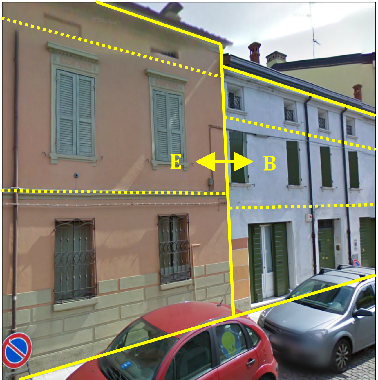
Estensione plani-volumetrica paragonabile con limitata interconnessione strutturale (differente altezza di gronda e sfalsamento nel livello degli orizzontamenti) Freccia a due punte: 2 UMI → unica Unità di Analisi (progetti strutturali sviluppati in forma partecipata)
