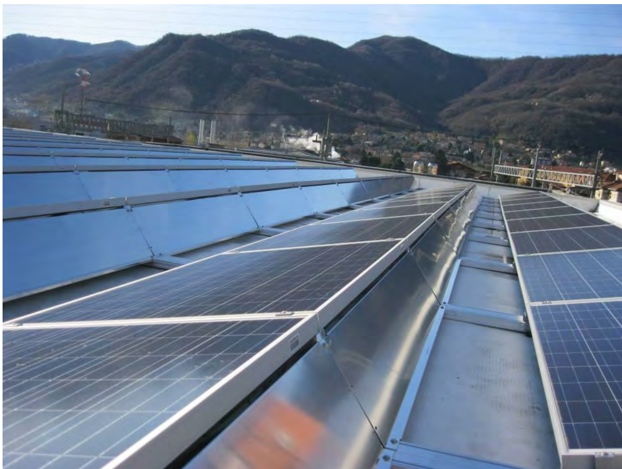
Impianto realizzato con soluzione auto-zavorrata – Dettaglio
